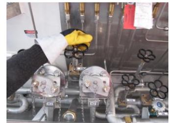
Ouvrir **V8** pour faire monter la pression de sortie de pompe. Si cette pression augmente trop, refermer la vanne.
