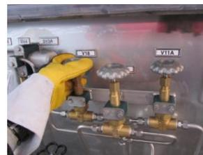
7- Purger le flexible liquide connecté (**DN50**). Pour cela, ouvrir **V35** pendant 5 secondes, la refermer puis purger la ligne en ouvrant la vanne de purge **V18** du conteneur.
