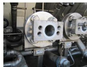
6- Purger le flexible **DN40** connecté. Pour cela, ouvrir la vanne de purge **V18** du conteneur puis légèrement la vanne phase gazeuse du réservoir receveur.
