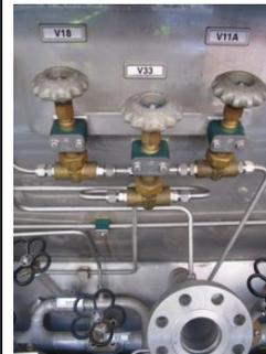
25- Contrôler que toutes les vannes du conteneur sont fermées et fermer les portes
